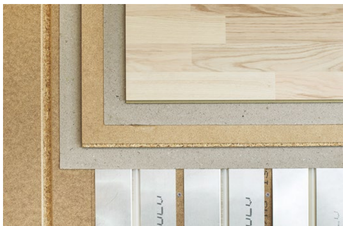
Figur 12 Man skall alltid lägga golvpapp mellan värmefördelningsplattor och undergolvsskivor, samt mellan undergolvsskivor och trägolv för att undvika knarr- och gnisselljud.
