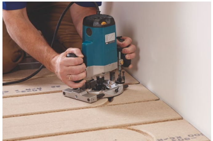
Figur 7 Fräsning av vändspår i varannan rad.
