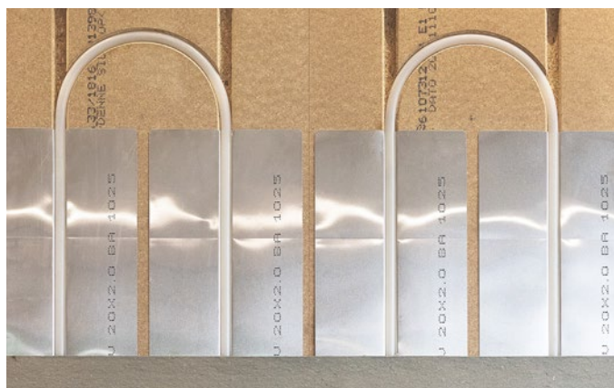
Figur 3 Värmefördelningsplattor till 16 mm värmeslangar, spåravstånd cc. 200 mm.
