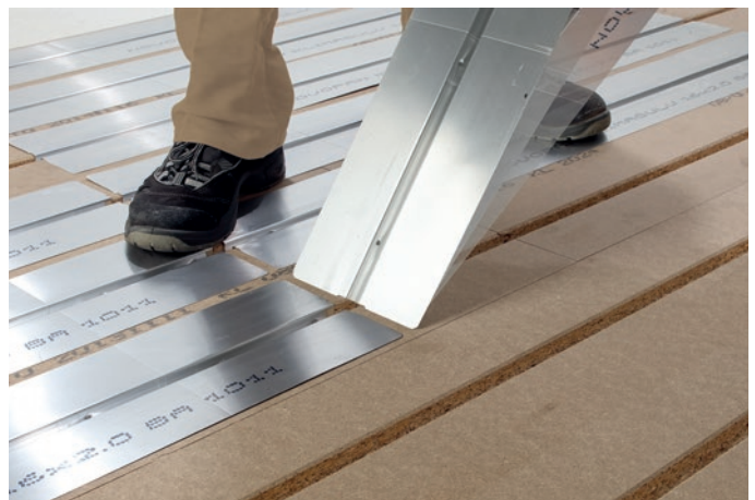
Figur 9 Värmefördelningsplattorna kan monteras stående.
